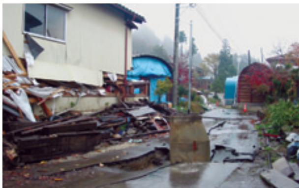
5. 堀之内町新道島に見られたマンホールの抜け上がり.
