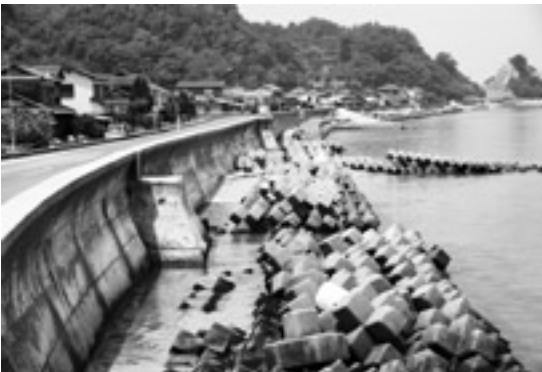
写真14 防潮堤下のテトラポッドの群.
