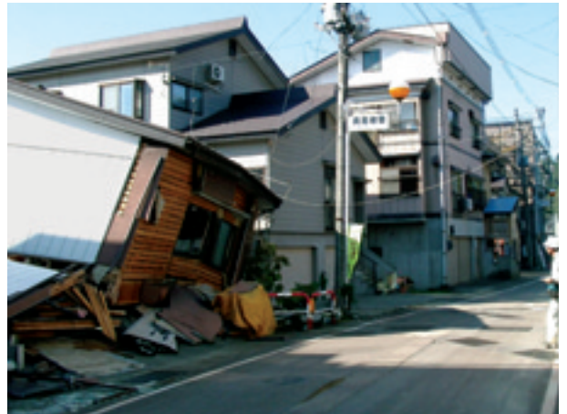
3. 倒壊した家屋。多数の古い家屋が倒壊したが、新しい家屋の被害は軽微なものが多い(川口町川口地区)。
