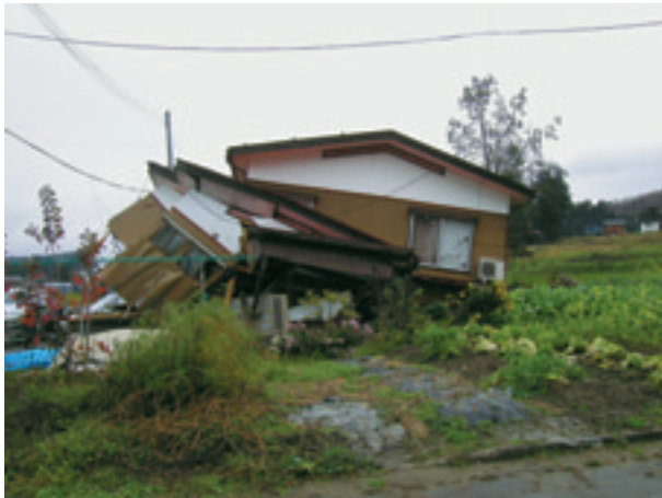
2. 倒壊した家屋。田麦山地区の緩斜面ではこのような被害が数多く見受けられた(川口町田麦山地区)。
