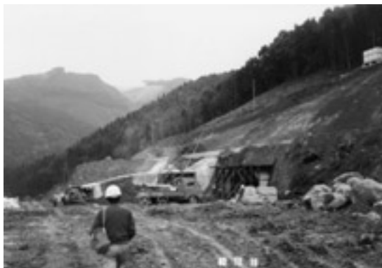
第9図 菱刈鉱山の斜坑口の工事。1982.12.16.撮影。
