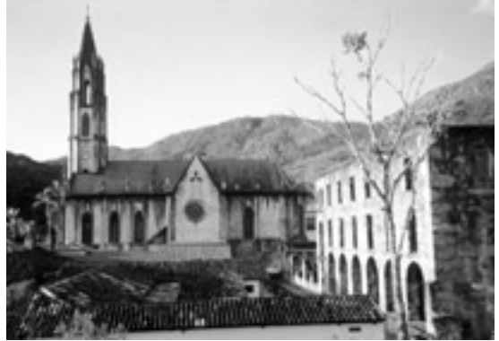
写真14 山間のガラシャ修道院。ここに一時泊した。
