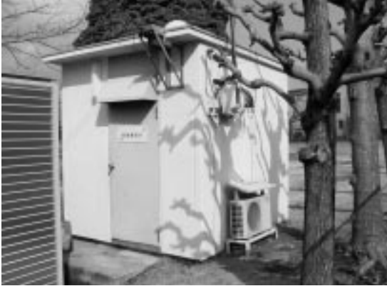
写真1 草薙観測井観測小屋。
