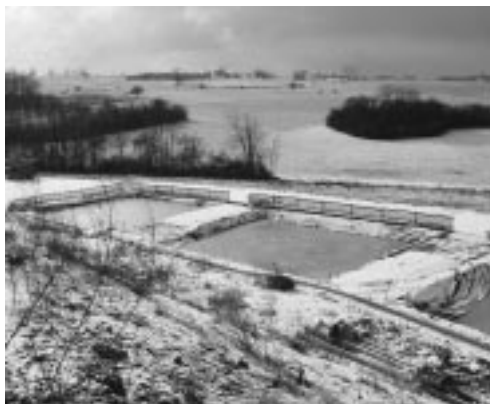
写真1 GPK3大規模水圧破碎のために準備が進められていた貯水池。
