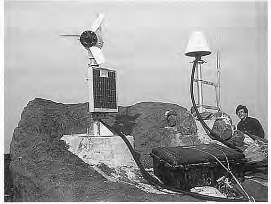
第2図 岩手山の山頂域に設置したGPS観測システムの一部。
