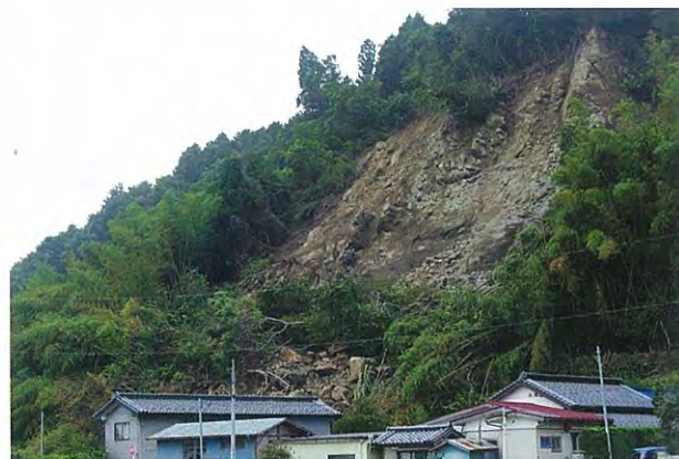
6. 矢本町矢本(鹿妻西方)の自然崩壊斜面で新たに発生した斜面崩壊(矢本町鹿妻)。崖直下の民家は危うく崩壊物の直撃をまぬがれた。中新統の“志田層群”根古層を構成する凝灰質砂岩が崩壊している。
