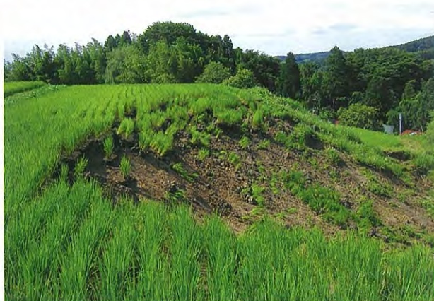
2. 河南町北村(久米田付近)で発生した地すべりの上部。地すべりが発生した丘陵では、第三系からなる尾根の頂部を平らに削って水田が造られていた。
