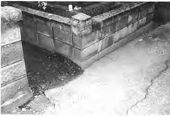
写真7 液状化による墓石の被害。液状化により墓石の土台が写真左下方向に傾いている。その上の墓石では傾きを補正するためにブロック片が使われている。土台の回りには噴砂痕が認められる(南郷町大柳; Loc.18)。
