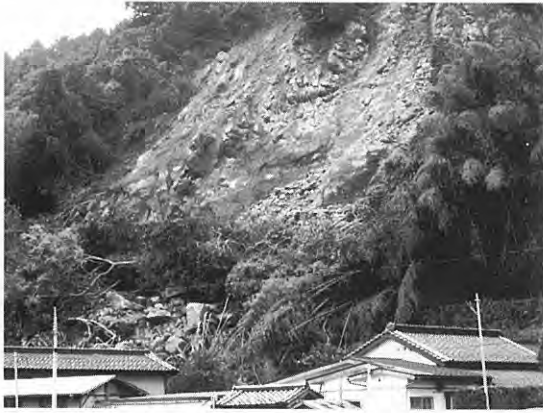
写真3 旭山丘陵の急崖での岩石崩壊。自然に形成されていた崩壊地で新たに崩壊が発生した(鳴瀬町鹿妻; Loc.8)。
