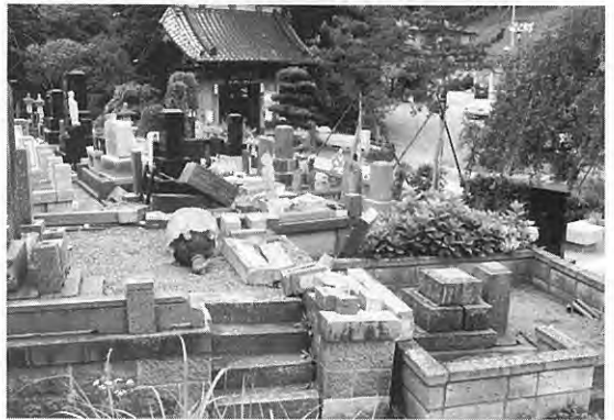
写真5 墓石の倒壊被害。古い墓石の大半は倒壊しているのに対して、黒い墓は鉄筋などの心棒で補強されているために被害は小さい(矢本町大塩地区の清泰寺; Loc.14)。
