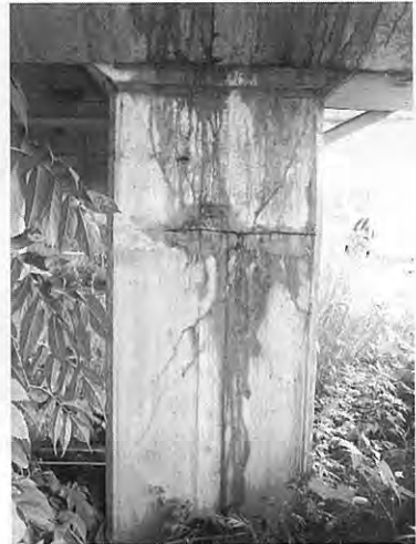
第3図 「大」に区分した橋脚(日詰駅北側にて)。
