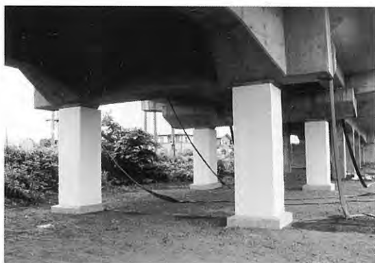
第4図 「特大」とした鋼板巻き補修後の橋脚。
