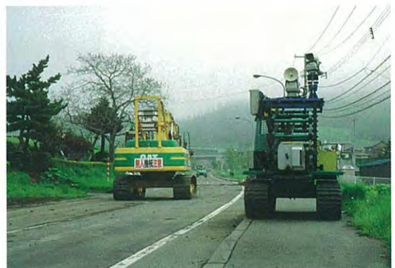
10. 虻田洞爺湖IC付近では無人の重機によって復旧作業が行われた(2000年5月23日撮影).
