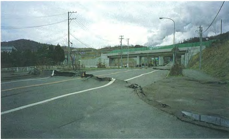
7. 虻田洞爺湖IC付近では、道路アスファルトの圧縮リッジや電線のゆるみが起きた(2000年4月16日撮影).
