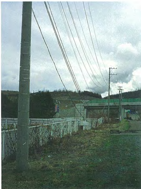
9. 電線のゆるみが顕著な区間では電線が地表に届きそうであった(2000年4月16日撮影).
