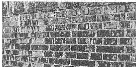
写真8 閘門正面の煉瓦の壁。古びた煉瓦が80年の歴史を感じさせる。壁の隅や水門取り付け部などには花崗岩のブロックが使われている。
