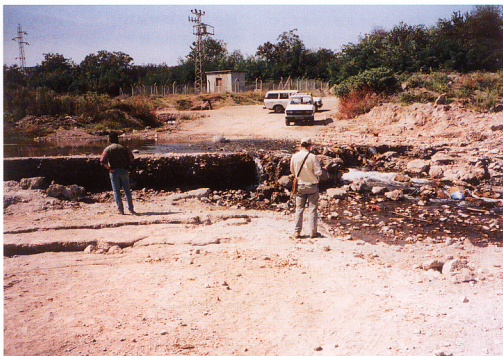
3. ギョルジュク東方におけるカズクル断層の変位、河床に約1mの段差ができ、滝になっている。
