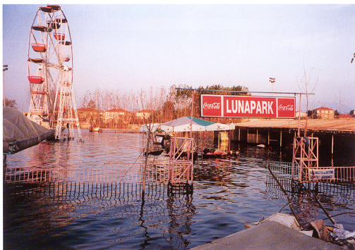
4. カズクル断層の変位に伴って海面下に水没した遊園地、断層の北側にあたる地域は1-3m沈降し、イズミット湾に水没した。
