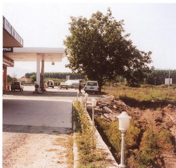
1. アリフィエ東方のガソリンスタンドの右横ずれ。もとは直線状にのっていた建物のへりを利用して4.1mの右横ずれを計測した。
