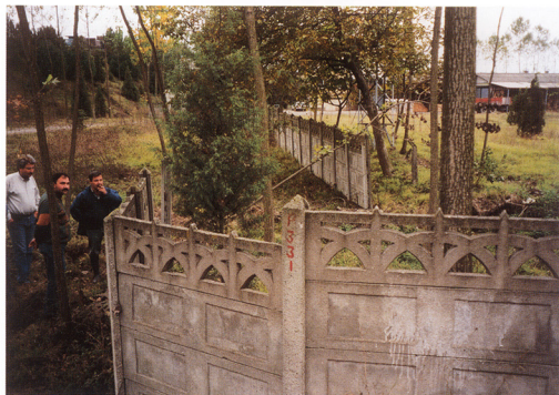
2. アリフィエ東方におけるコンクリート塀の右横ずれ。ここでの右横ずれ量は4.5m。
