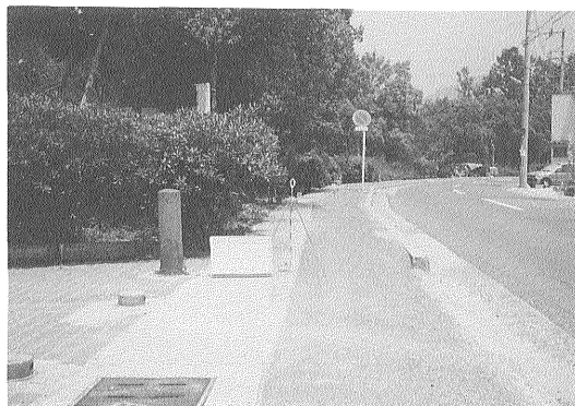
第2図 金属板測点の例。 中央のボール直下に測点。路線1-1の測点No.40。
