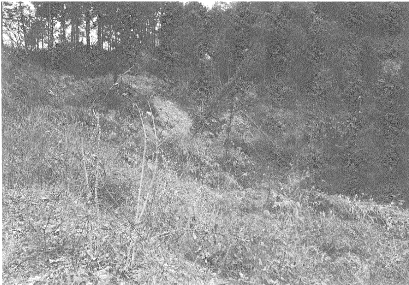
1. 地すべり状態 (左上は滑落崖, 測点No. 3の北方)
