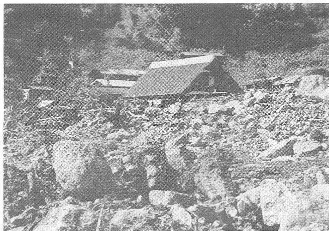
3. 根場部落の土石流。山際の家は残っているが家の中は土石で埋まっている。
