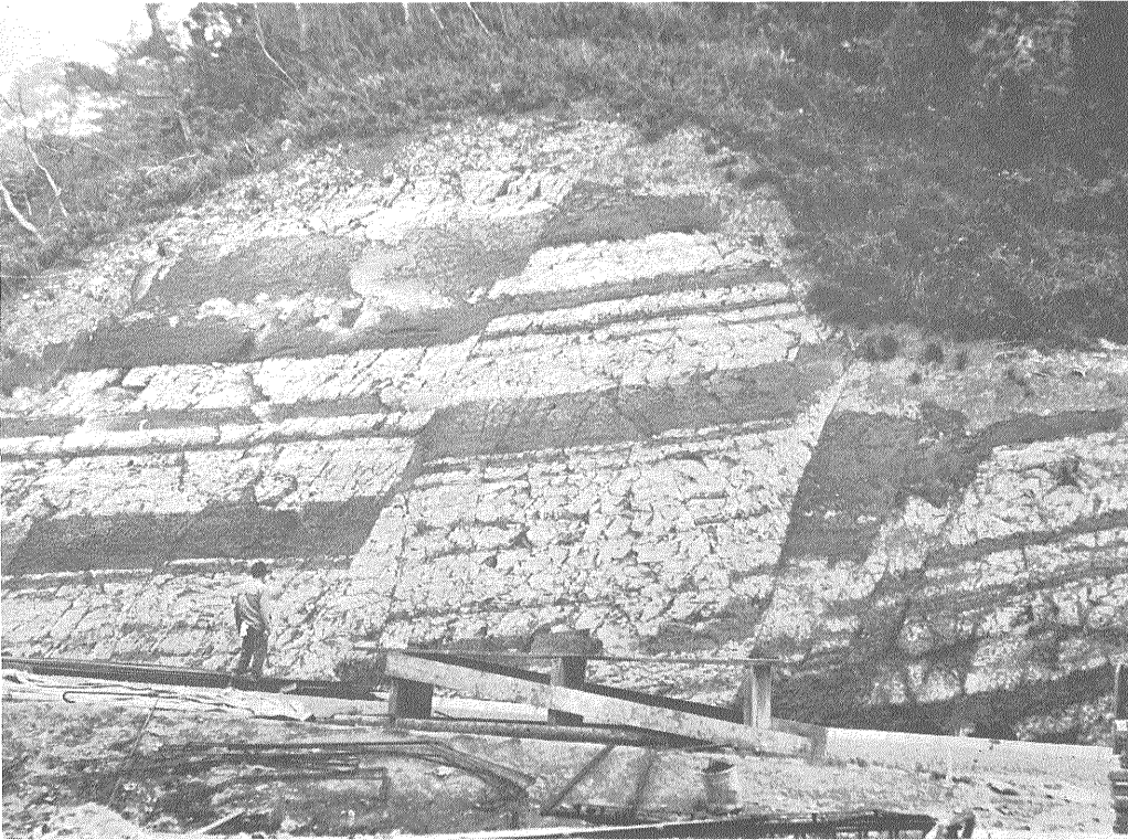
1 Y-NS系断層. 直線的で落差は比較的大きい。平行な断層群をなす。
