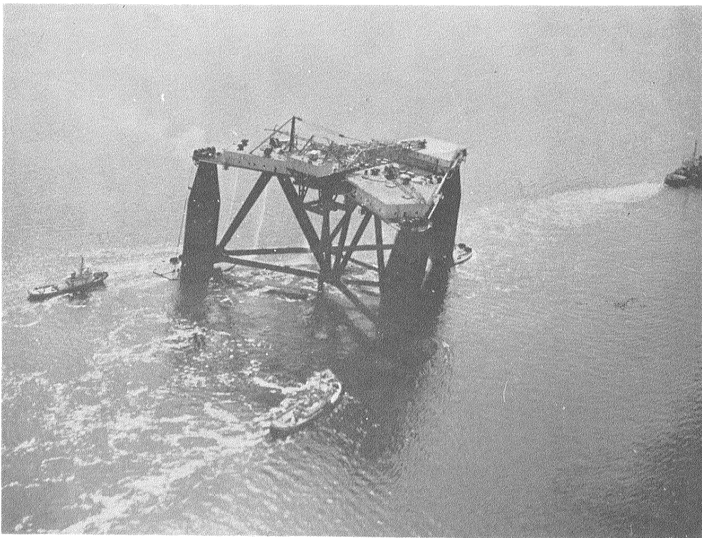
第7図 半沈潜型 (SEDCO 135) 掘削装置
