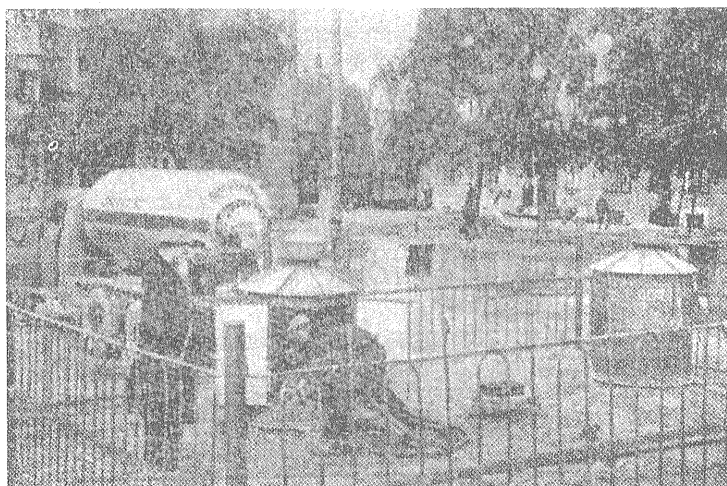
第 9 図 自動タンク車から住宅地付属地下タンクへの液化ガス注入
