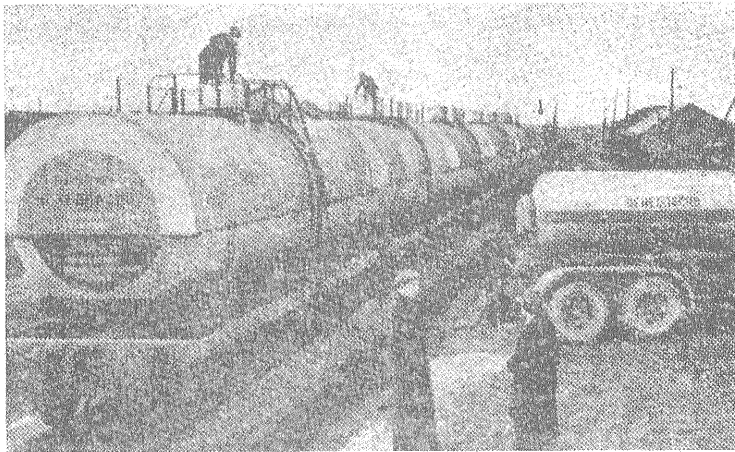
第8図 特殊な鉄道タンク車から自動タンク車への液化ガス注入
