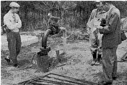
図版 4 常陸台地におけるゴルフ場用水源井 一般に台地の地下水は地上からの汚染がない限り良質である。台地の緑地帯は地下水涵養林としての役割をはたしている。
