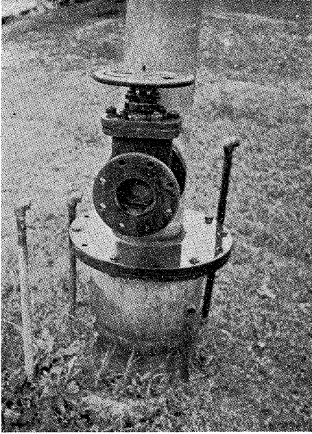
図版 1 わが国で最初にキャリヤ排水の地下圧入に成功した東洋レーヨン K. K. 瀬田工場の圧入専用井 4本の細いパイプはセメントグラウテイング用のもの
