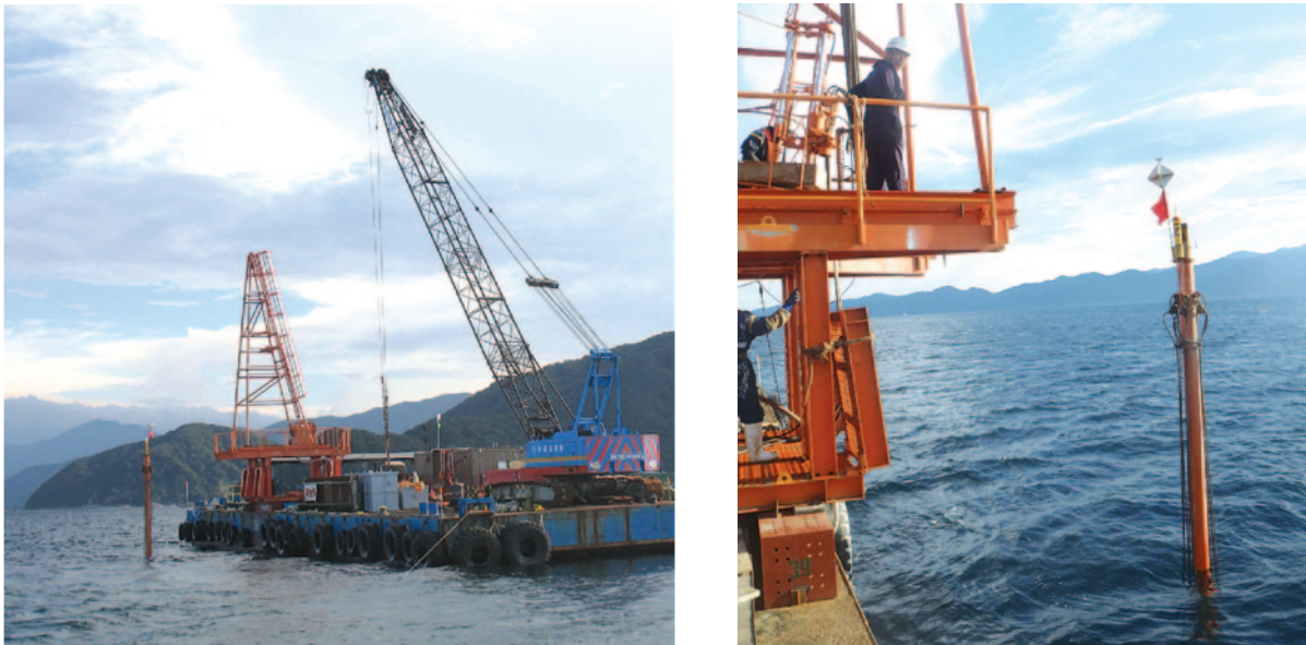
第 17 図. ガイドパイプを台船から隔離した様子. 掘削作業休止時及び夜間の係留時には，台船が波浪で大きく動揺してもガイドパイプと台船が接触しないように，両者を適切な距離に隔離することができる.
