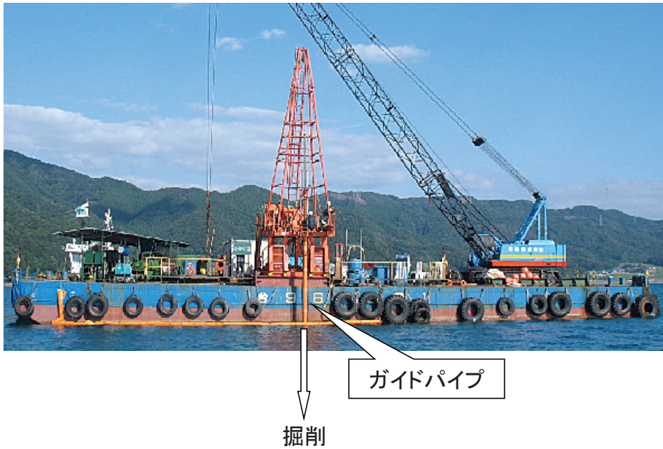
第 16 図. 傾動自在型試錐工法. この工法では，クレーン台船にボーリング檣，試錐機，発電機などを仮設し，クレーン台船の外側に，掘削ロッド・サンプラーなどを通すガイドパイプを独立に仮設する.
