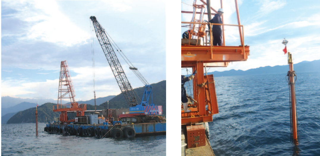
第 18 図. ガイドパイプを台船から隔離した様子. 掘削作業休止時及び夜間の係留時には, 台船が波浪で大きく動揺してもガイドパイプと台船が接触しないように, 両者を適切な距離に隔離することができる. Fig. 18. A guide pipe being separated from the pontoon survey ship. This drilling method keeps the guide pipe off the pontoon survey ship in order not to contact each other even in stormy condition.
