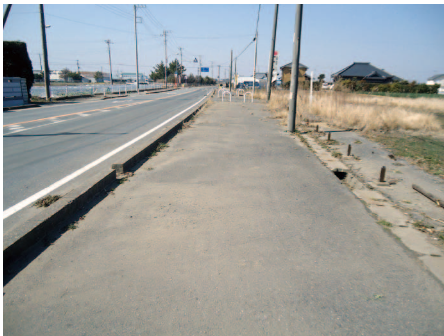
第8図. フィルム状に道路を覆う津波堆積物(2011/3/13). 泥質砂層からなる. 海岸から約700 mの位置で陸側を見る.
