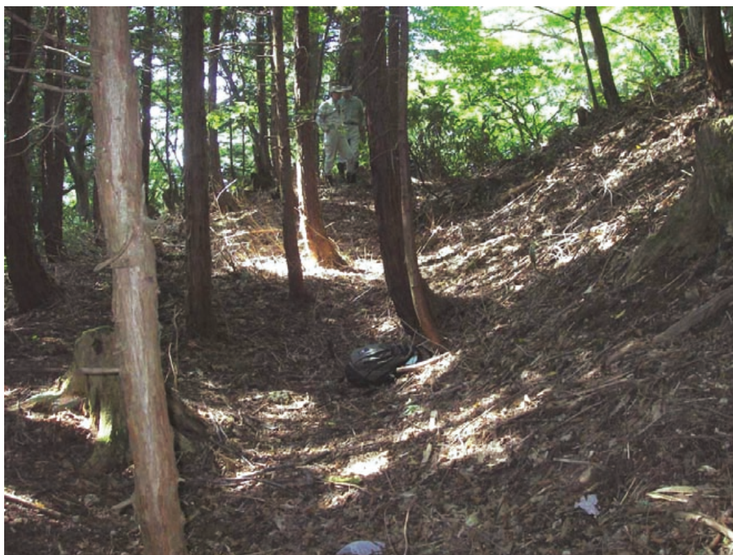
第 20 図. 餅谷 A ピット掘削地点の地形. Fig. 20. Fault scarp at the Mochidani A site.
