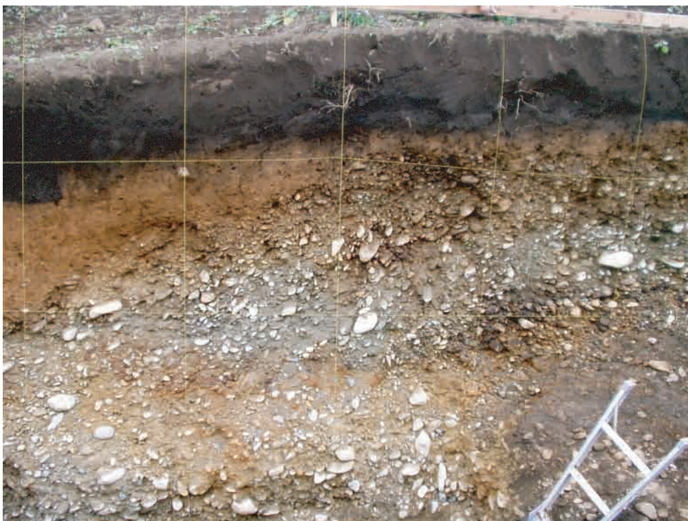
第7図．箱根ヶ崎 B トレンチ北西壁面断層部の写真. Fig. 7. A photograph of fault zone of trench B (NW wall).
