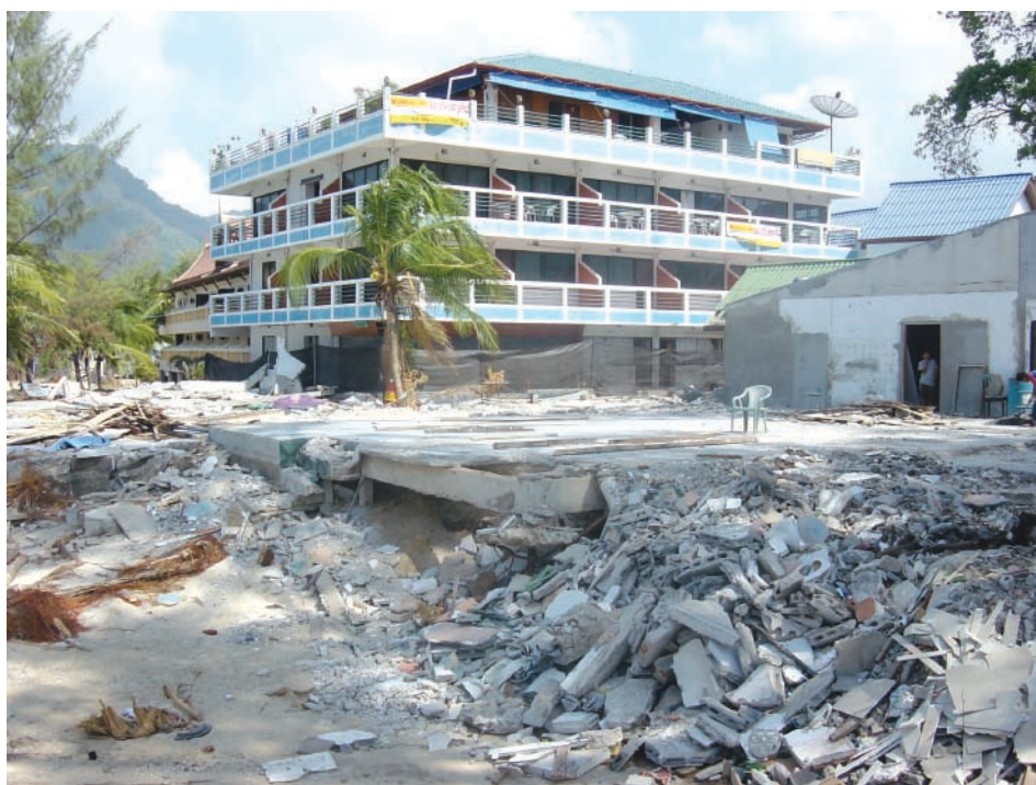
第2図. プーケット島Kamala beachにおける津波被害. Fig. 2. Tsunami damage on Kamala beach in Phuket.
