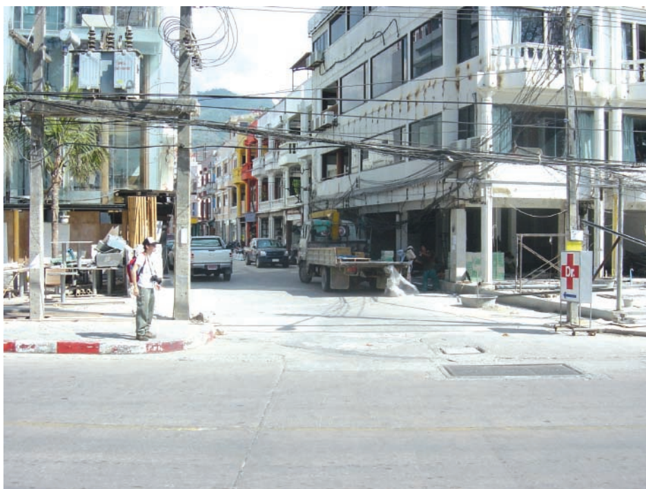
第4図. プーケット島Patong beachにおける津波被害. Fig. 4. Tsunami damage on Patong beach, Phuket.
