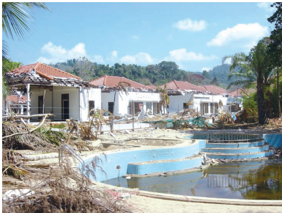
第9図. Ban Khao Lakにおけるリゾートホテルの津波被害. Fig. 9. Tsunami damage to hotel in Ban Khao Lak.
