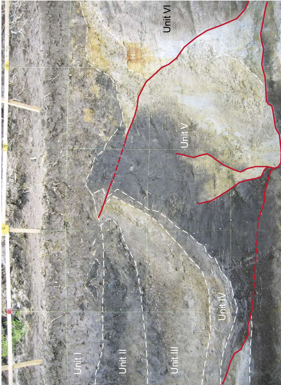
第4b図、崩落前のトレンチ北東壁面の断層部分、写真範囲は第4a図に示す。赤線は断層（破線部は不明瞭）、白破線は堆積ユニットの境界を示す。Unit I中の細破線で囲まれた部分はUnit IIの腐植質土壌からなるブロック。
