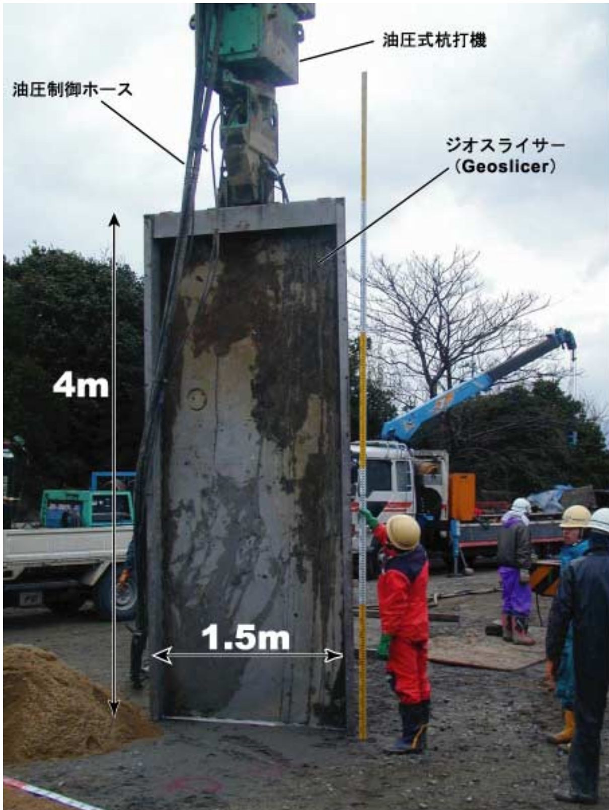
写真3. ジオスライサー本体の打込み.
