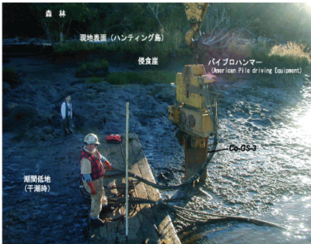
写真1. サンプラー(鋼矢板) 打込み作業. Photo 1. Driving the Geoslicer (sheet pile).
