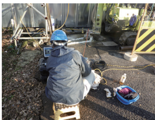
モニター画面を見ながら定速でプローブを降下させつつ画像を取得している状況
