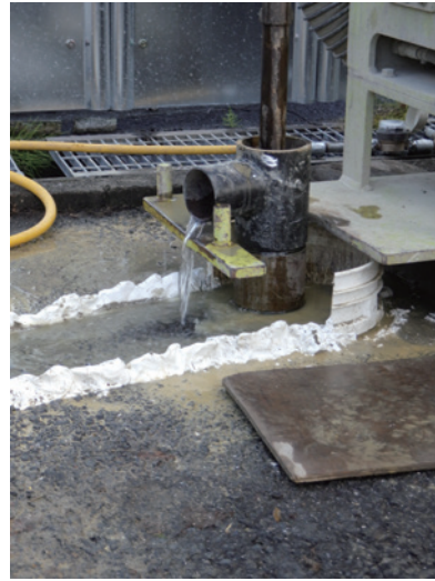
孔内洗浄終了頃にボーリング 孔からあふれ出す水
