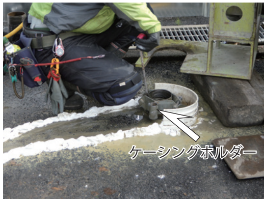
ボーリング孔の中心を決めるガイド (ケーシングホルダー)
