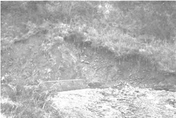
図版 15 田野川本流に設けられた砂防ダム 対岸は崩壊地に等しく、ほとんど岩屑のみからなる。
