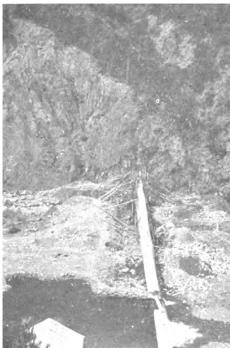
図版 16 田野川本流における砂ダム建設状況 対岸の露頭は著しく擾乱した頁岩層からなり、写真でみられる通り崩壊性甚だしく、基礎岩盤として適当ではない。
