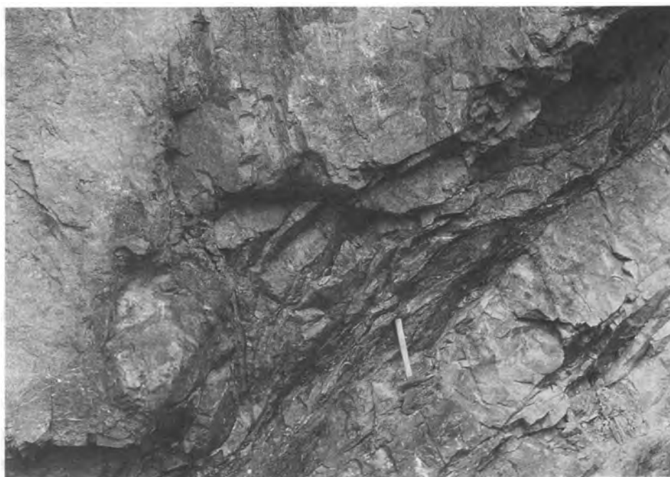
第19図 上鷲谷層の赤色ハイアロクラスタイトと赤色層状チャート（下鷲谷-元山部林道） ハンマーの部分が高イロクラスタイト。
