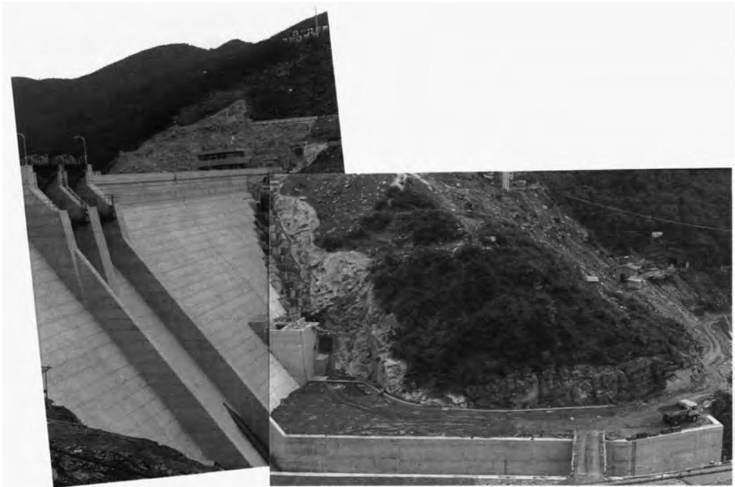
第64図 神浦ダムサイト南岸におけるダム基底部の受け盤状況を示す泥質片岩の片理
