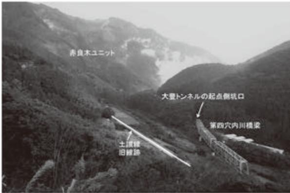
第9.19図 路線付け替えで、道路に転用された土讃線の旧線跡と新設された第四穴内橋梁と大豊トンネル
