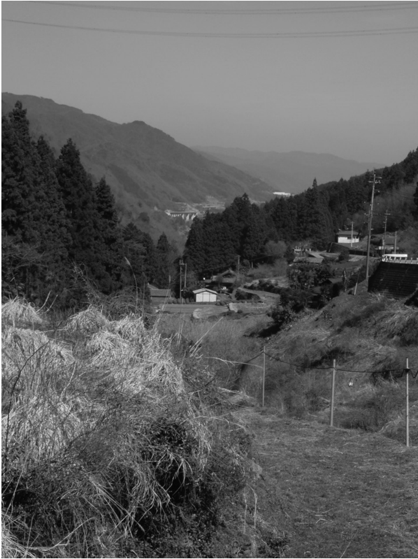
第 10. 3 図 池田断層の遠景 愛媛県と徳島県の県境の境目峠付近から東北東方向に池田断層を望む。
