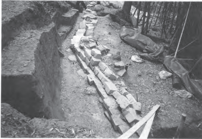
第70図 酒船石遺跡で検出された石垣の崩壊跡
