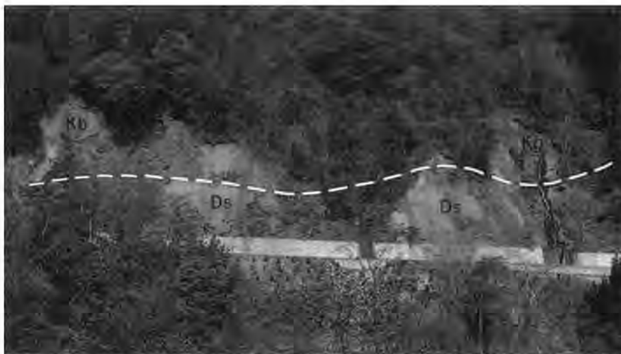
第16図 丹生川村駄吉林道切割にみられる 駄吉衝上断層 駄吉層 (Ds) の上に N35°E, 30-50°NW の断層面をもって小八賀川層 (Kb) が載っている
