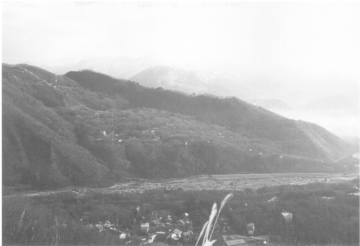
第78図 岩葦山南方のどんぐり地区の地すべり地形（写真中央部） 西方より撮影。
