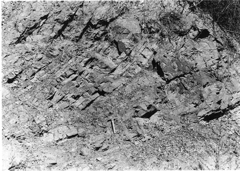
第10図 泥岩砂岩互層を起源とする変成岩のシェブロン型転倒褶曲 林道赤ジッコ線
