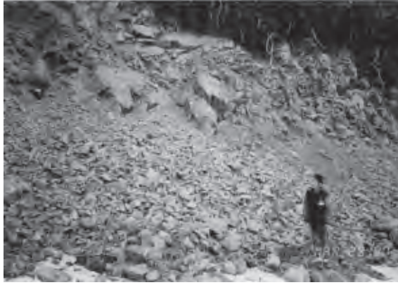
第5.4図 縦ヶ崎溶岩層（野尻湖北岸） 風化の進んでいる部分が多い。
