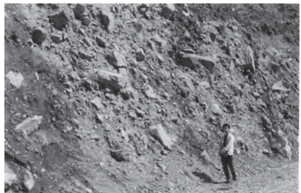
第5.32図 なべわり川岩屑なだれ堆積物 (氷沢川右岸) 同じ種類の岩片のみからなる脆い集合物のブロックを多数含む。
