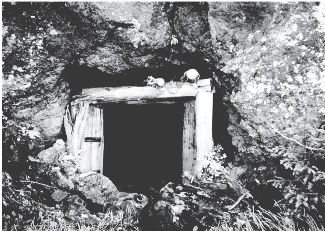
第 8. 7 図 龍起鉱山, 立岩の坑道跡 立岩付近には少なくとも 2 つの坑口を確認したが、立岩は高さ約 30 m だが、上部にも採掘したらしき窪みが見える。この坑道は高さ約 1.5 m あり、奥行き数 m で材木でふさがれていた。立岩の前には巨大な岩塊が散在(北緯 37 度 47 分 00.5 秒, 東経 140 度 11 分 21.3 秒)。
