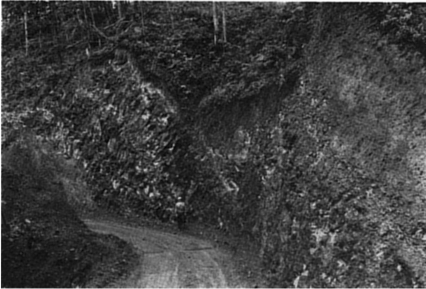
第17図 素波里安山岩の溶岩とこれを覆っている同質の火砕岩 (二ツ井町窓山北西方約1.6kmの梅内沢下流付近)
