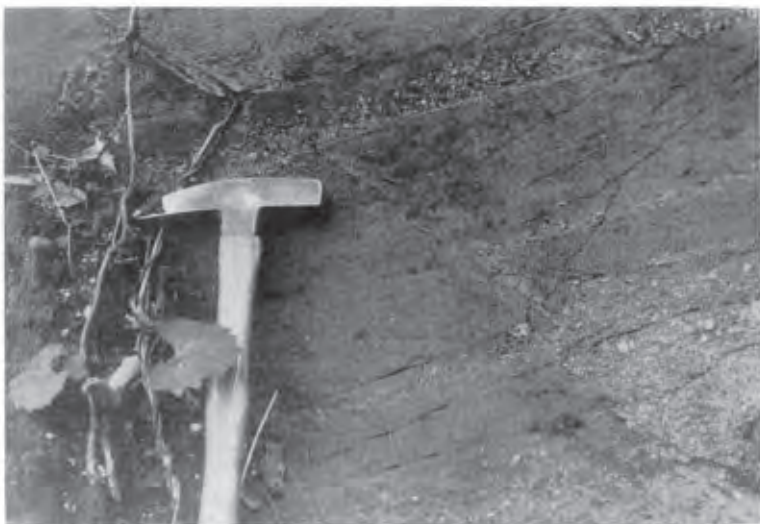
図版 15 塩越層にみられる層内断層(母沢)
