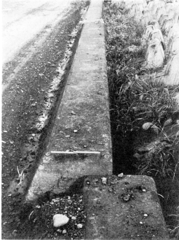
第27図 地沁りによって移動した海岸擁壁（猪の狛付近） 擁壁は施設後約9年を経過している。
