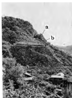
図版4 ポントマリにおける岩石の崩壊状況 巨大な岩塊aの下部に跡永賀炭坑の旧坑bがかくされて現在では入口は確認できない
