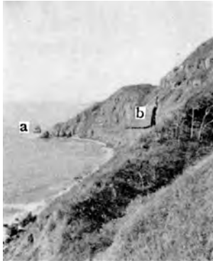
(A) 天寧礫岩層中の亀裂(十町瀬カンノン坂附近から西方の立岩を望む)。
