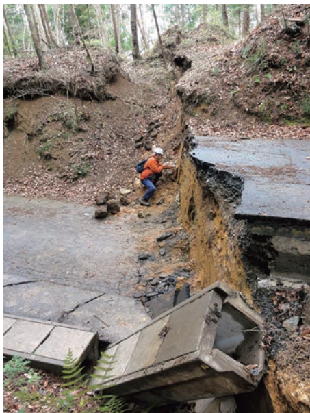
写真1 地震断層により上下に食い違った道路（井戸沢断層）。
